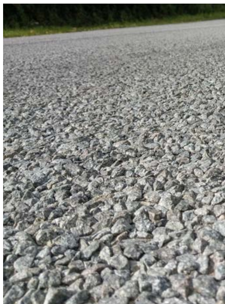
Устройство тонкослойного покрытия по технологии Чип Сил
