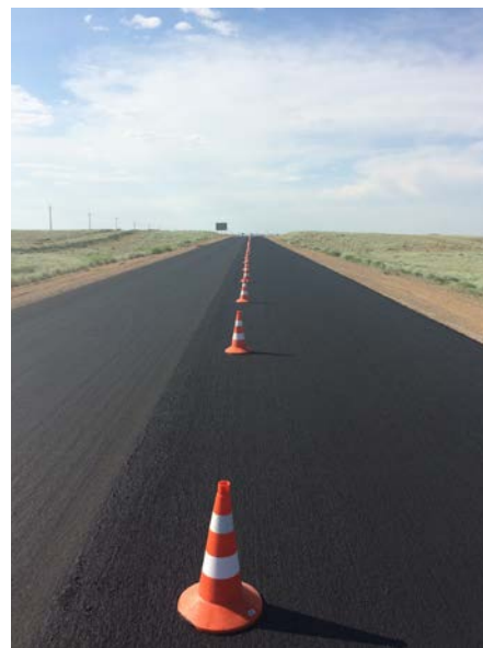
Устройство тонкослойного покрытия по технологии Микросюрфейсинг
